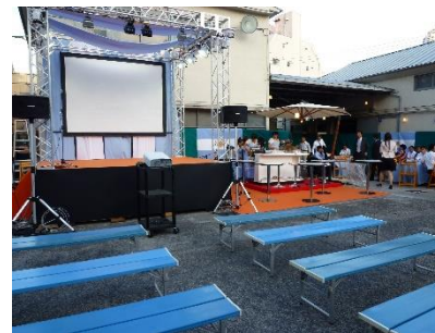
屋外・屋内ステージ設営
