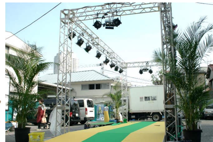
トラスとシステムステージで ダンサーの舞台を設営
