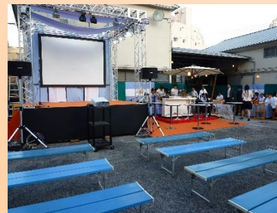
屋外・屋内ステージ設営
